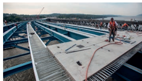
Mostovka mostu Mario M. Cuomo Bridge je sestavena z téměř 6000 prefabrikovaných panelů o délce 3,66 m a šířce 6,7–13,7 m pro nájezdové panely a z 963 hlavních mostových panelů. Panely jsou spojeny zalitím betonu kolem vyčnívající žárově zinkované výztuže. (Obrázek s laskavým svolením ředitelství silnic státu New York)
