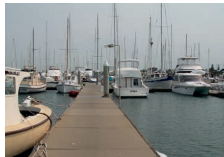
Plovoucí pontony v přístavu v Sandringhamu ve Victorii (Austrálie) s použitím žárově zinkované výztuže
