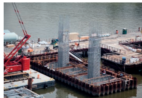
Více než 27 000 tun žárově zinkované výztuže zajišťuje dlouhodobou odolnost hlavních mostových pilířů, pilířů nájezdových polí, opěr a silničních panelů mostu Mario M. Cuomo Bridge.
