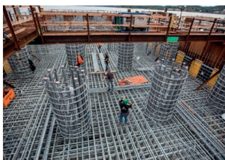
Před návrhem žárově zinkované výztuže pro most Mario M. Cuomo Bridge ředitelství silnic státu New York vytvořilo plán ochrany proti korozi, který měl identifikovat expozici, mechanismy degradace, strategie konstrukčního řešení a výstavby a náklady na celý životní cyklus mostu.
