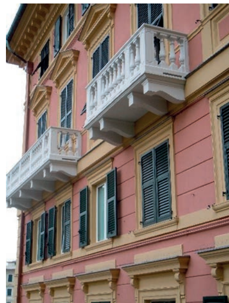
Železobetonové nosné trámy pro balkony elegantního bytového domu v Janově s použitím žárově zinkované výztuže. Byla vybrána žárově zinkovaná výztuž, aby se nosné trámy balkonů co nejdéle zachovaly v dokonalém stavu a zejména aby byly ochráněny před smogem, deštěm, mrazem a vlhkostí. (Obrázky s laskavým svolením Prefabbricati Torti di Pietro e Lino Torti snc)
