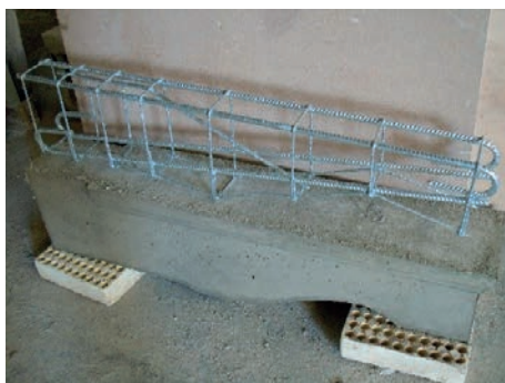
Železobetonové nosné trámy pro balkony elegantního bytového domu v Janově s použitím žárově zinkované výztuže. Byla vybrána žárově zinkovaná výztuž, aby se nosné trámy balkonů co nejdéle zachovaly v dokonalém stavu a zejména aby byly ochráněny před smogem, deštěm, mrazem a vlhkostí. (Obrázky s laskavým svolením Prefabbricati Torti di Pietro e Lino Torti snc)
