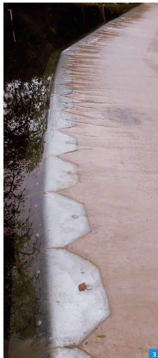
3 | Koruna jezu obdržela z technických a estetických důvodů podjezí z žárově zinkované oceli.
