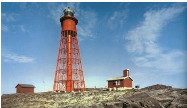
Obr. 11-1 – Maják Pater Noster je jednou z prvních švédských konstrukcí s duplexním povlakem. V roce 1868 byl žárově pozinkován a potom opatřen nátěrem.
