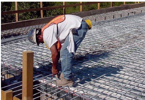
Obr. 10-16 – Žárově zinkovaná armatura v mostní konstrukci.
